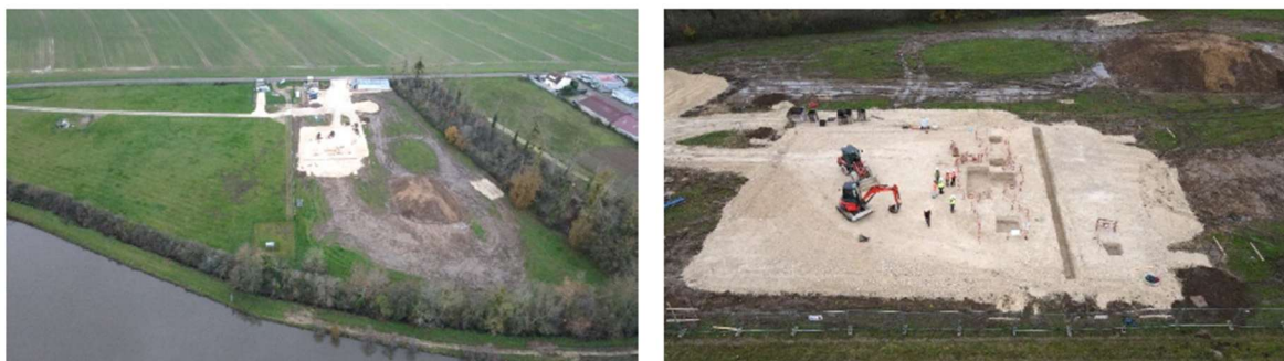
Avancée des travaux (photo prise par drone fin novembre 2025)
